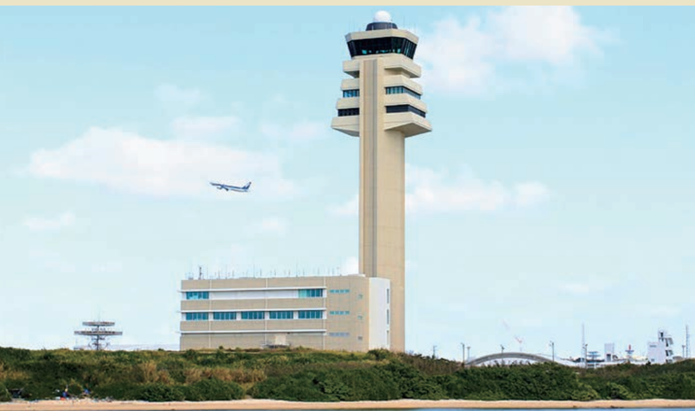
那覇空港新管制塔
